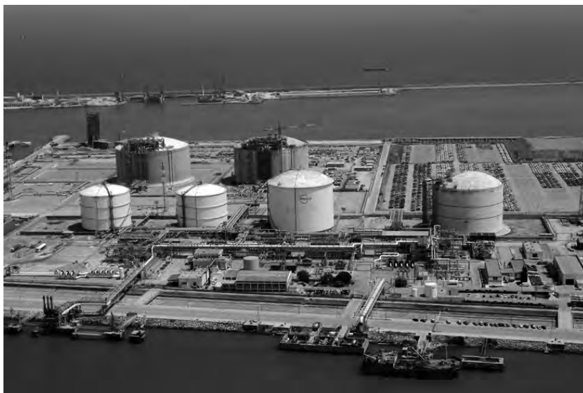
Moll de l'Energia del port de Barcelona. Font: Diario del Puerto .
