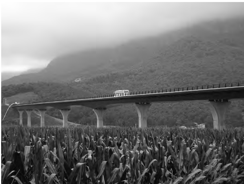
Viaducte de Can Trona. Font: Arxiu Territori.
