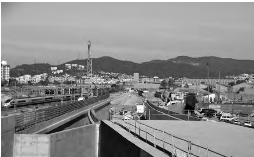
Obres a Sant Andreu - la Sagrera. Font: Néstor Cabañas.
