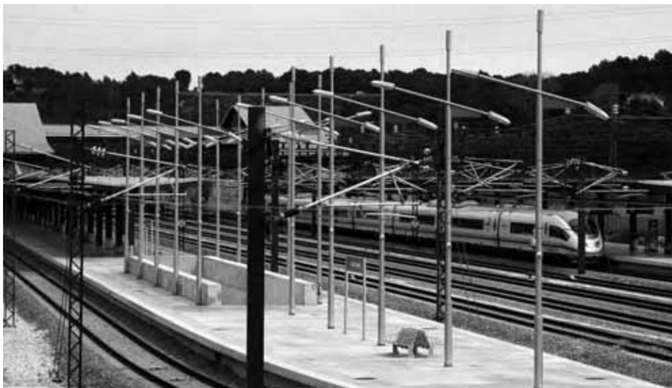
El TGV a l'estació del Camp de Tarragona Foto: Àlex Tarroja
