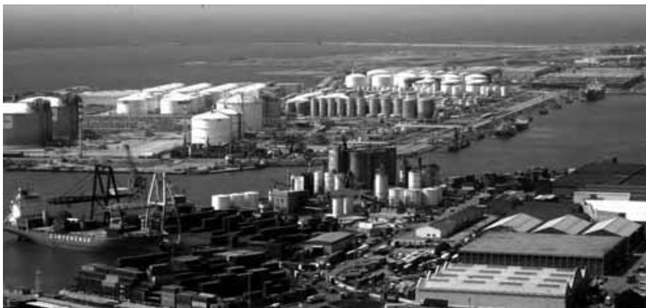
Vista del moll d'infamables amb les obres del dic sud al fons. Foto: Àlex Tarroja
