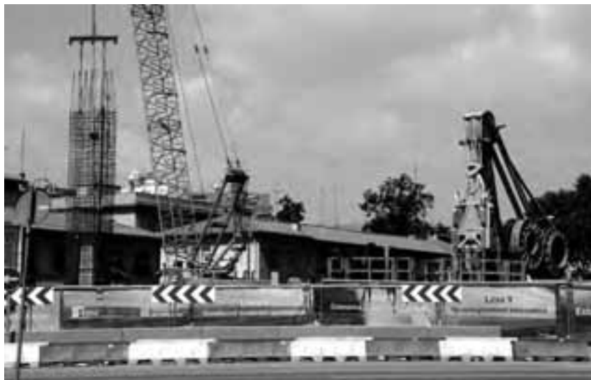
Obres de l'intercanviador de la Sagrera Foto: Àlex Tarroja
