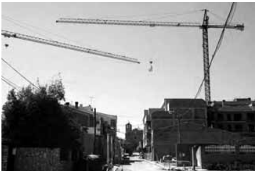
Alcarràs té una important activitat de construcció d'habitatges. Foto: Àlex Tarroja
