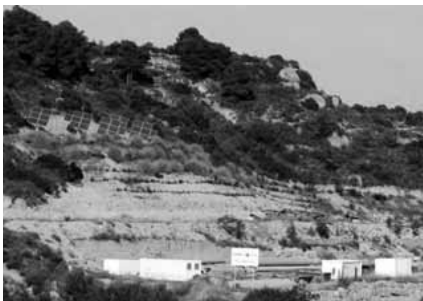
Obres de construcció d'un parc solar a Juncosa, les Garrigues. Foto: Àlex Tarroja
