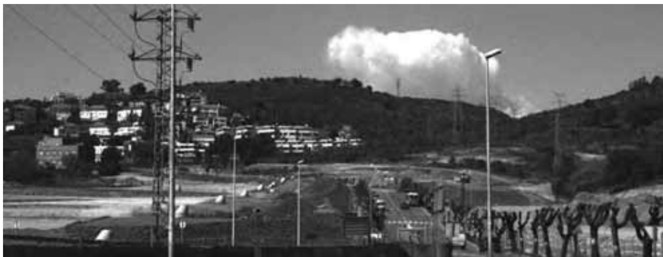
Obres d'urbanització del Pla CAUFEC-Porta de Barcelona Foto: Àlex Tarroja
