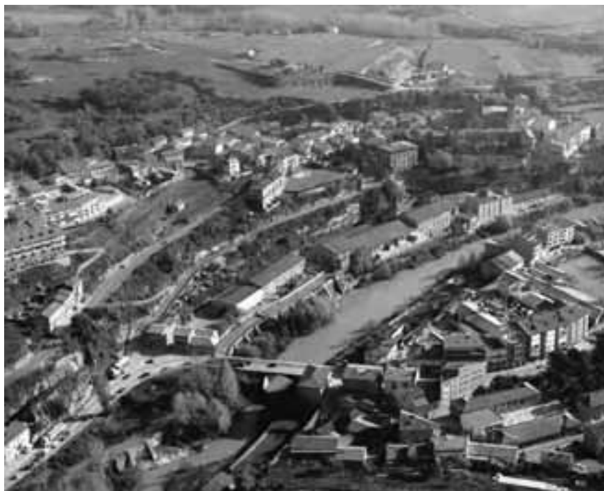
Colònia industrial de Cal Metre, dins el nucli de Gironella. Foto: CCRS Arquitectes
