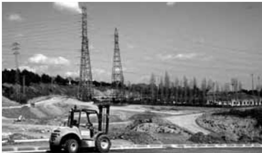
Obres d'urbanització del Pla CAUFEC-Porta de Barcelona Foto: Àlex Tarroja
