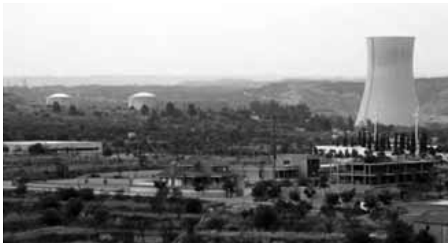
Centrals nuclears i torre de refrigeració d'Ascó. Foto: Àlex Tarroja
