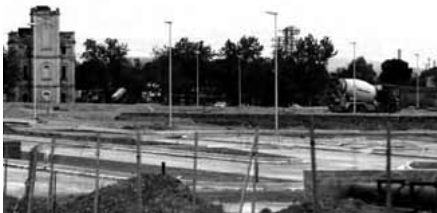
Obres d'urbanització del Parc Tecnològic del Camp a Bellissens Foto: Àlex Tarroja
