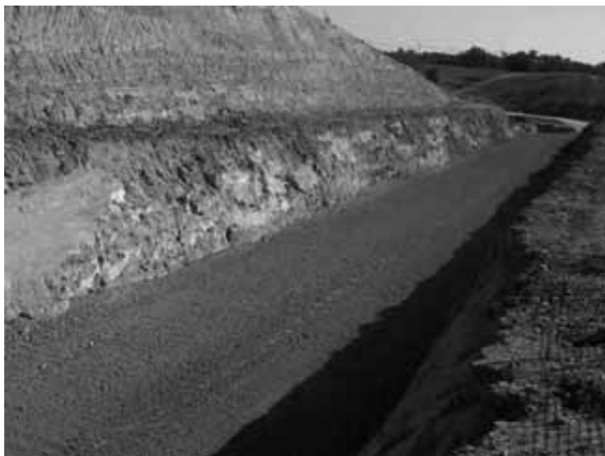
Aspecte de l'excavació de la caixa del canal a les proximitats del nucli urbà de Ponts (31-10-2006). Foto: CASEGA
