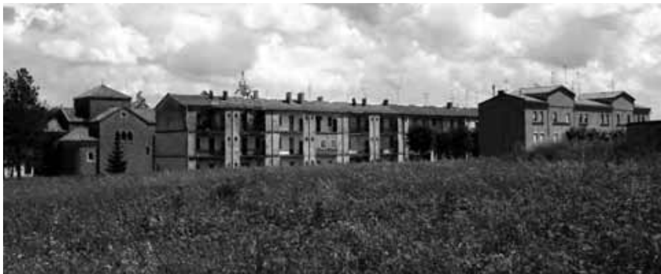
Vista parcial de la colònia Can Vidal, a Puig-reig. Foto: Àlex Tarroja
