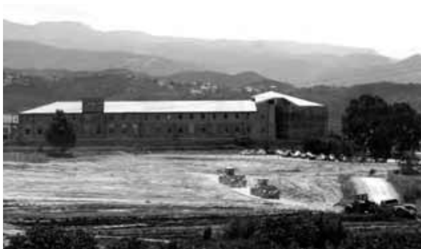
Obres del futur Parc Tecnològic de la Catalunya Central, des de l'estany de l'Agulla. Foto: Àlex Tarroja
