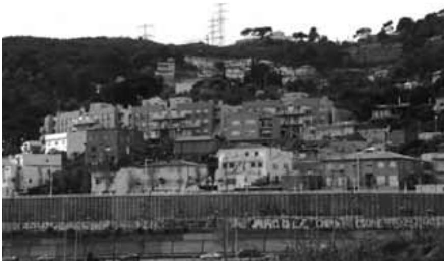
Habitatges al carrer Martorelles de reallotjament d'afectats per enderrocaments Foto: Àlex Tarroja
