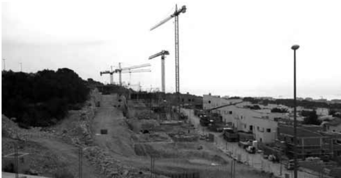
Obres d'ampliació de la urbanització Mas Mel Foto: Àlex Tarroja
