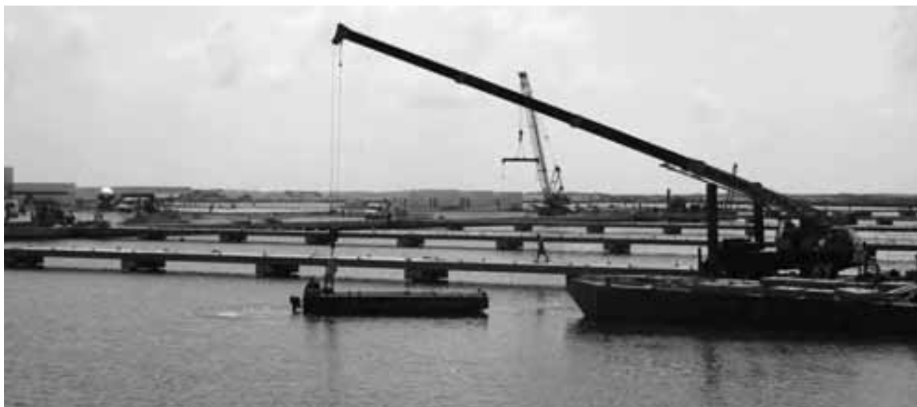
Obres de construcció del port esportiu de la Ràpita. Foto: Àlex Tarroja
