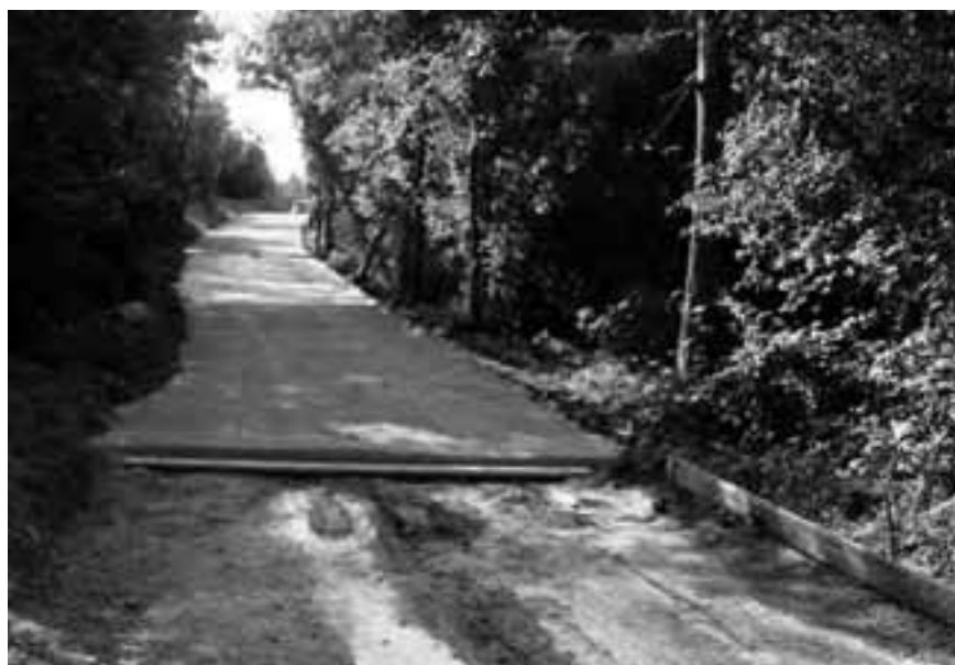
Obres de pavimentació en el tram entre Lliurona i Coll de Tenes. Foto: Àlex Tarroja
