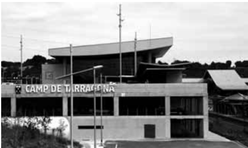
Estació del Camp de Tarragona Foto: Àlex Tarroja
