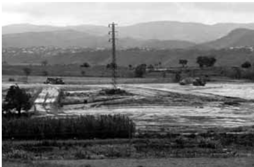
Detall de les obres del futur Parc Tecnològic de la Catalunya Central. Foto: Àlex Tarroja
