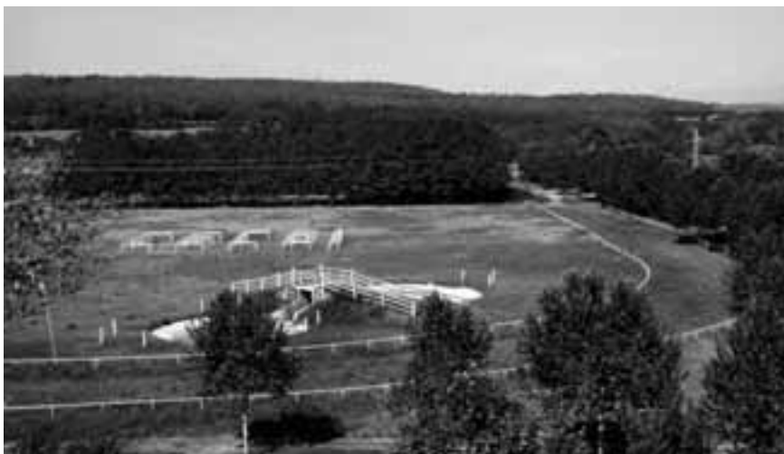
Hipòdrom del parc de la Resclosa, afectat per les obres del FAV. Foto: Àlex Tarroja
