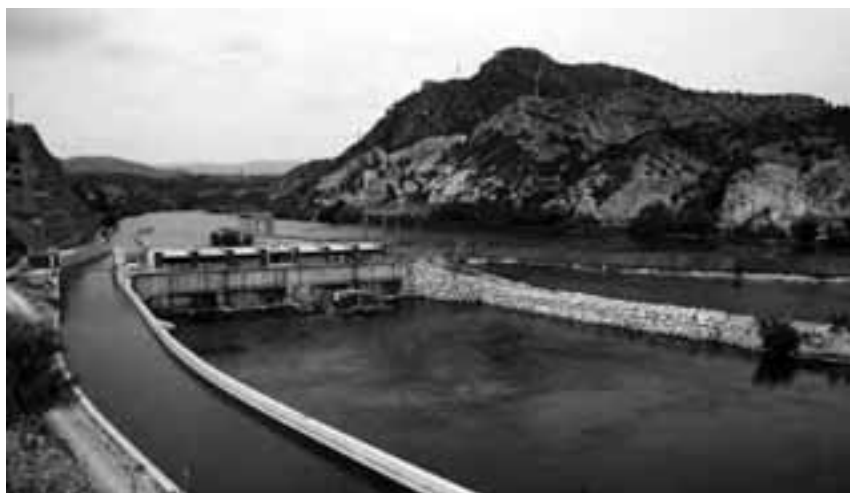
El canal que salva l'Assut de Xerta permet la navegabilitat de l'Ebre. Foto: Àlex Tarroja
