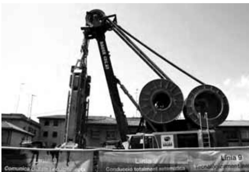
Obres de l'intercanviador de la Sagrera Foto: Àlex Tarroja
