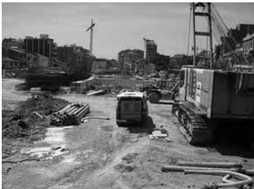
Una imatge de les obres a l'Illa Fradera Foto: Moisès Jordi
