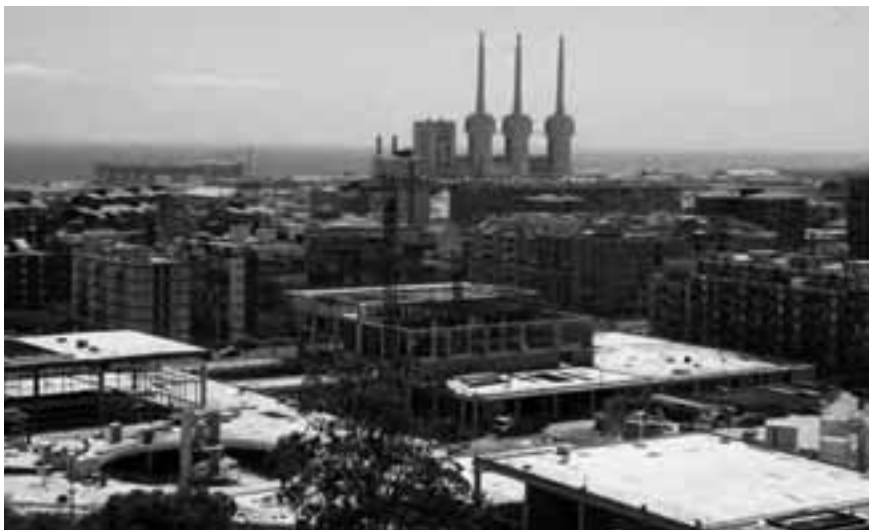
Obres del centre comercial de la futura Ciutat del Bàsquet. Foto: Àlex Tarroja
