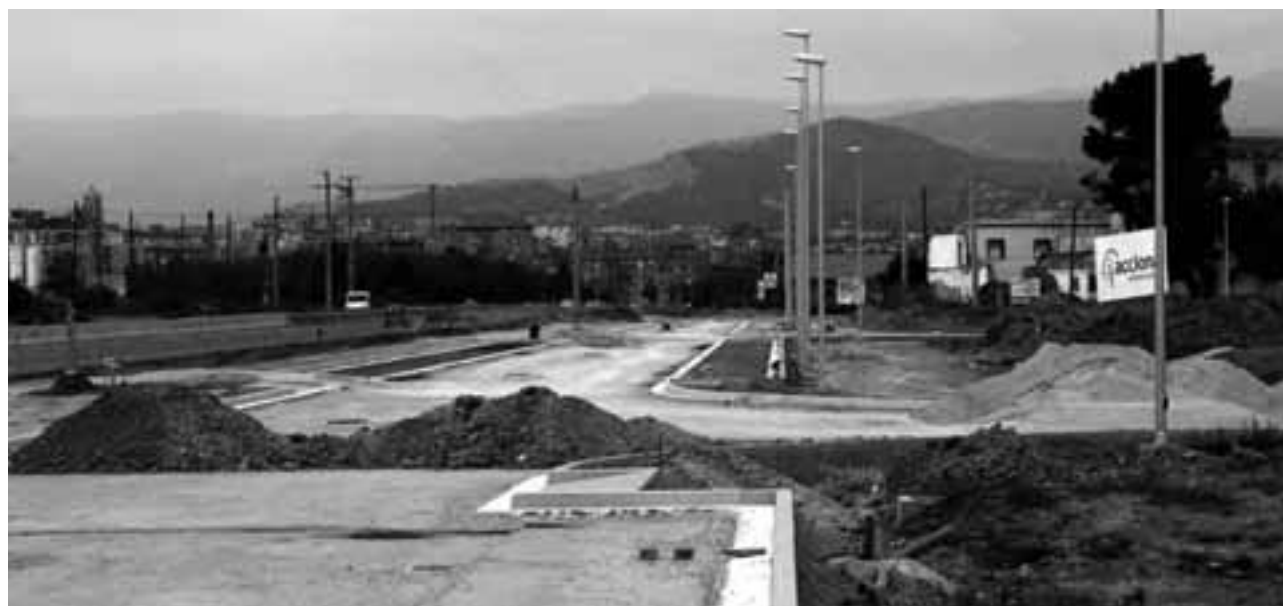
Obres d'urbanització del Parc Tecnològic del Camp a Bellissens Foto: Àlex Tarroja
