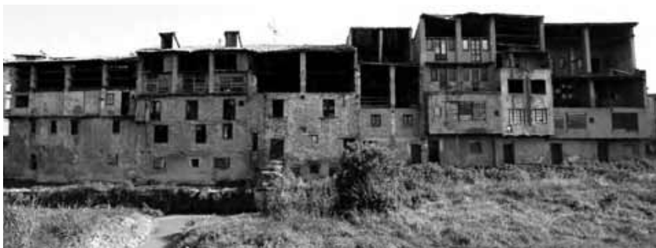
Façana de les Adoberies al riu Mèder. Foto: Àlex Tarroja
