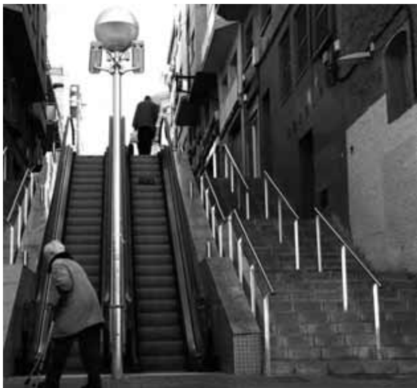
Instal·lació d'escaleres mecàniques al carrer París a Collblanc, l'Hospitalet de Llobregat Foto: Àlex Tarroja
