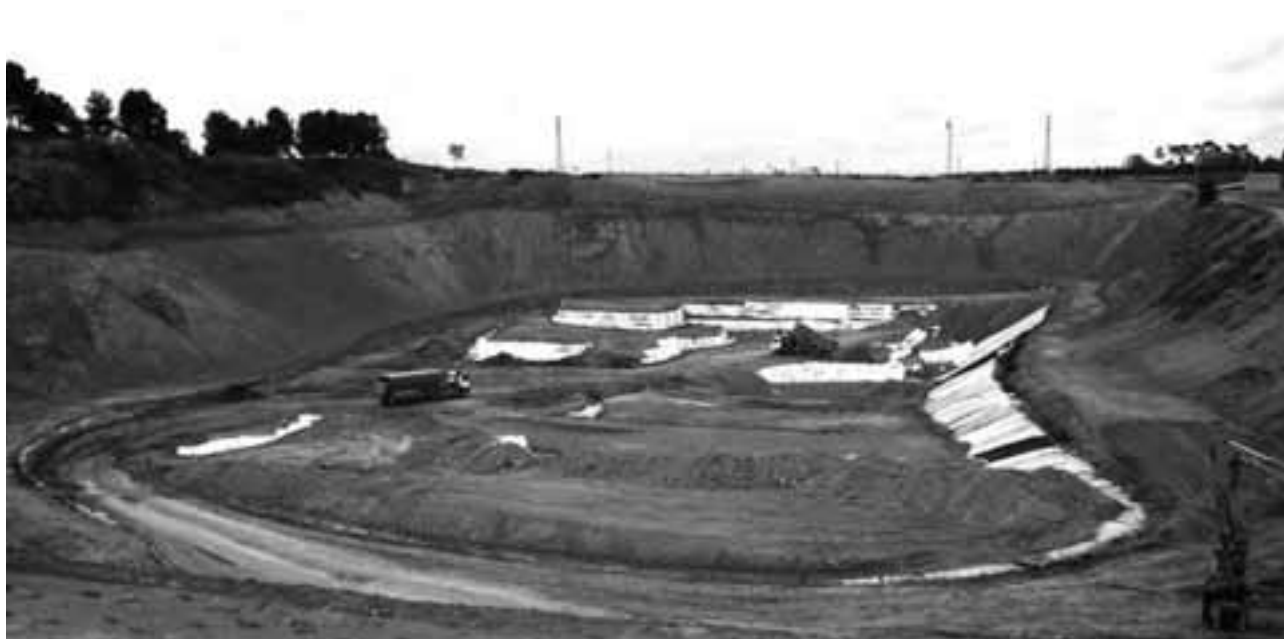
Operacions de reompliment de l'argilera Elena amb material de reciclatge Foto: Àlex Tarroja
