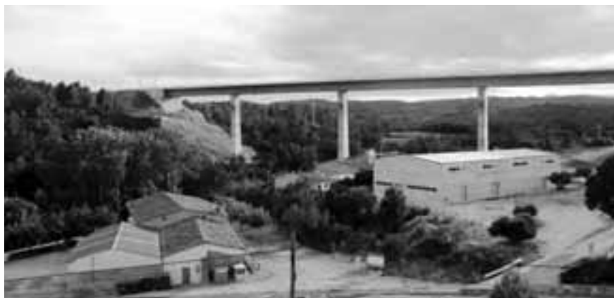
Viaducte del FAV a Pont de Molins. Foto: Àlex Tarroja
