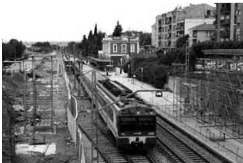
Obres de soterrament del ferrocarril a Montmeló Foto: Àlex Tarroja
