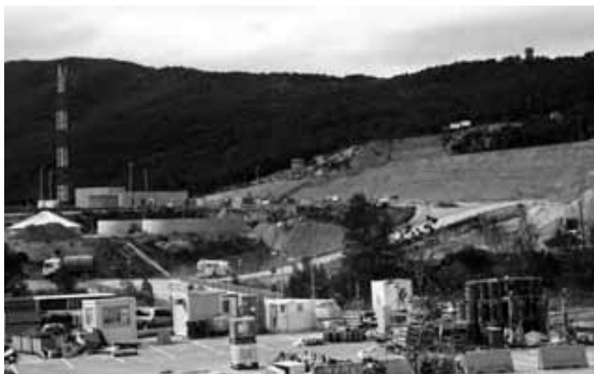
Obres del túnel del Pertús. Foto: Àlex Tarroja
