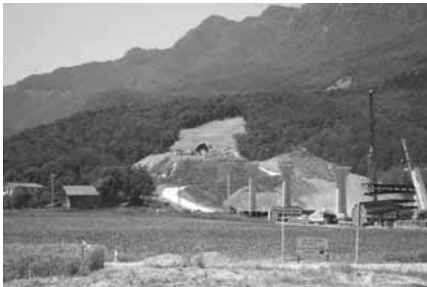
Obres de la C-37 entre la sortida del túnel de Joanetes i el veïnat de Can Trona Foto: Moisès Jordi
