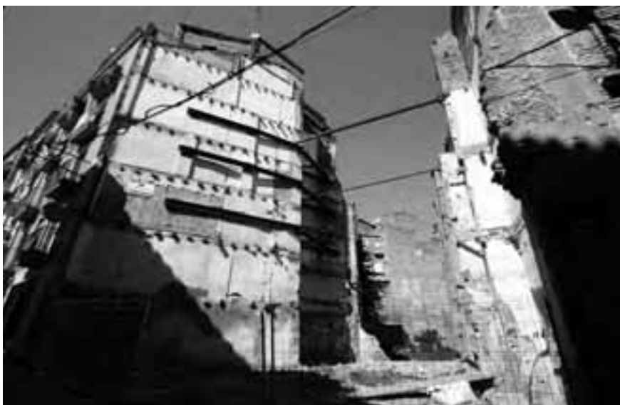
Un edifici del carrer Cavallers es va esfondrar provocant una víctima mortal. Foto: Àlex Tarroja
