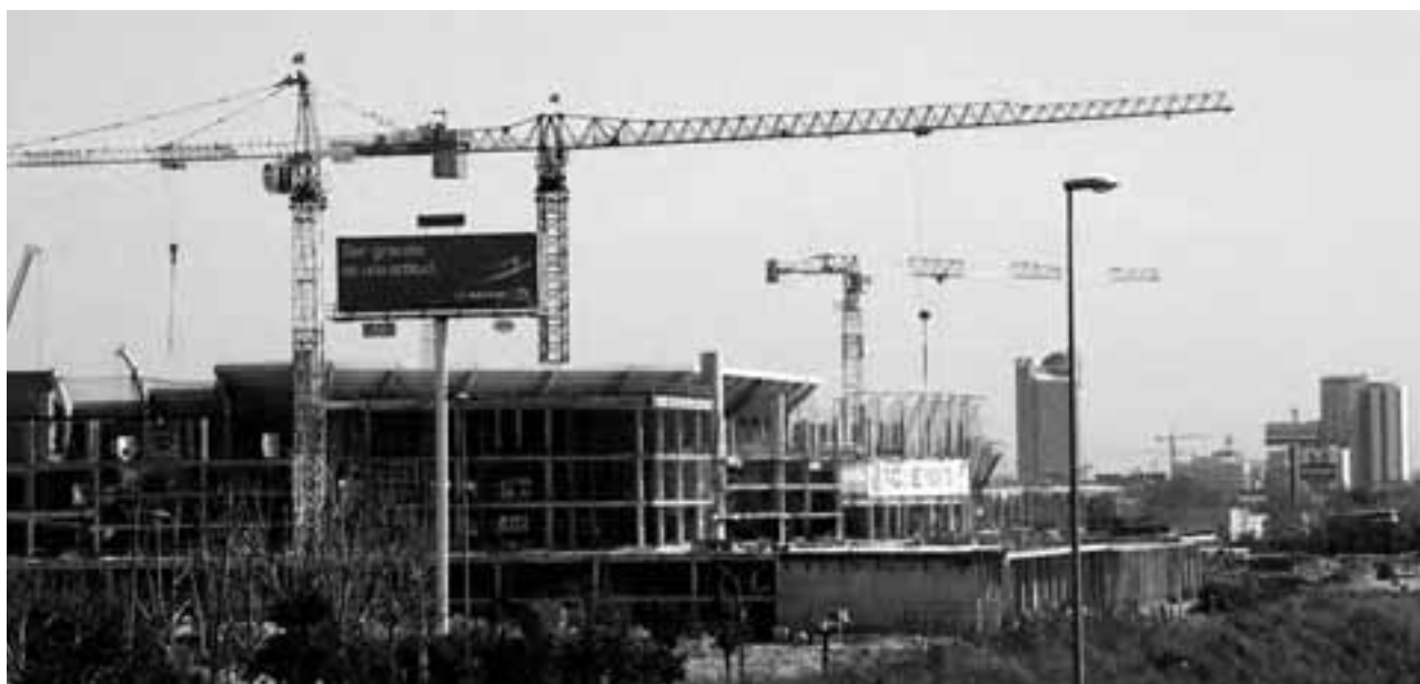
Obres de construcció del nou estadi del RCD Espanyol Foto: Àlex Tarroja
