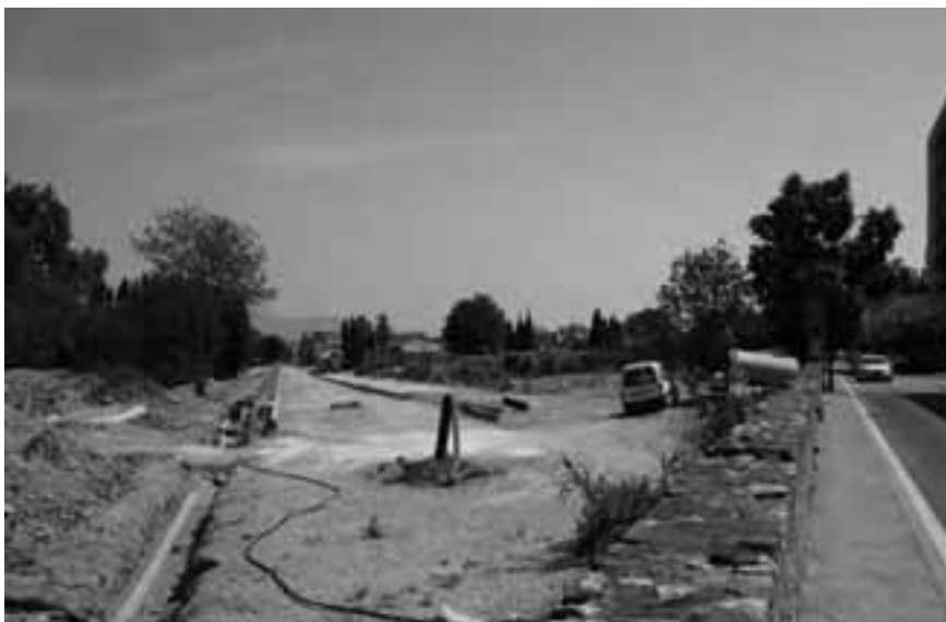
Obres d'urbanització del Pla Avinguda Costa Brava. Foto: Juli Valdunciel
