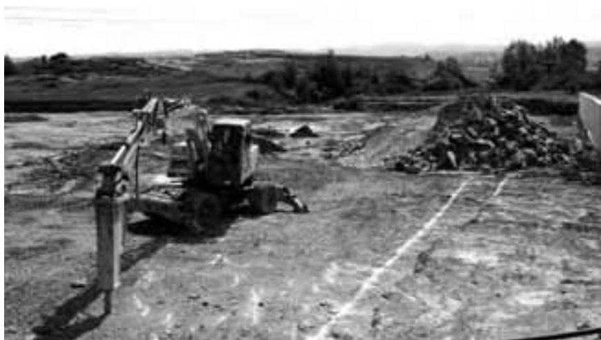
Obres d'ampliació de la zona esportiva on hi havia el Torrental. Foto: Àlex Tarroja
