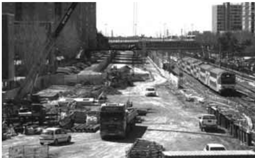
Cobertura de l'estació de rodalies de Bellvitge Foto: Àlex Tarroja
