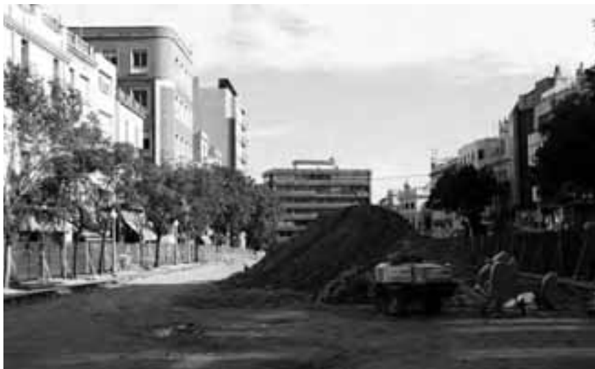
La Rambla en obres per la construcció de la nova estació dels FGC. Foto: Àlex Tarroja
