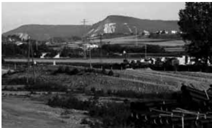
Obres d'urbanització aturades al sector del Graell. Foto: Àlex Tarroja
