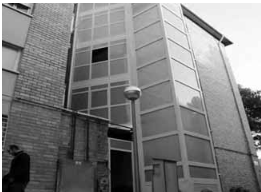
Instal·lació d'ascensors al polígon de l'Espirall de Vilafranca del Penedès Foto: Àlex Tarroja
