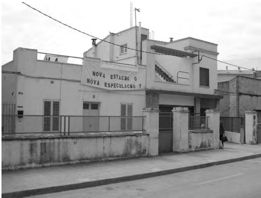
El juliol de 2005 es va fer públic el pla de transformació urbana de l'avinguda de la nova estació de Figueres. Foto: Juli Valdunciel Coll
