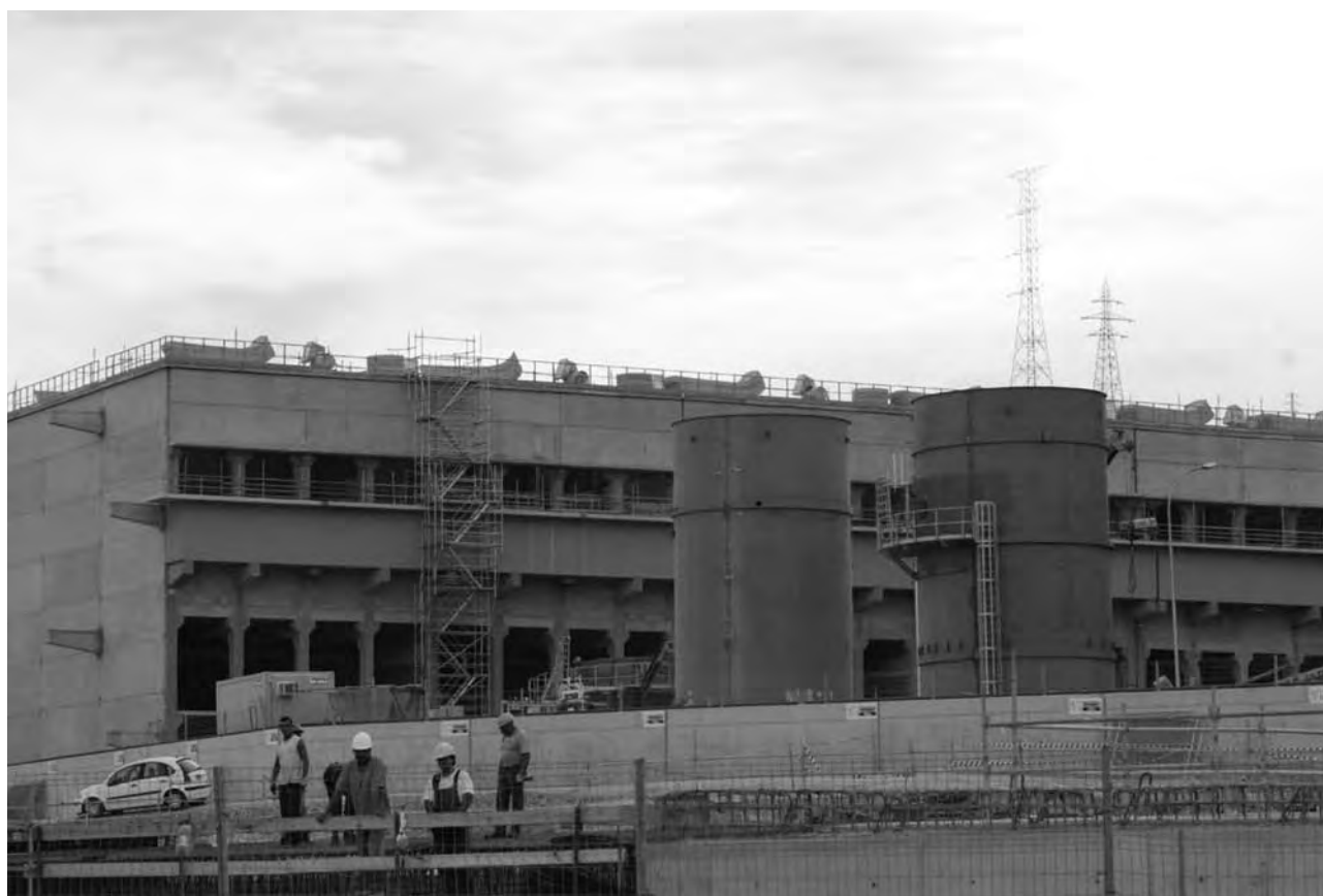
La instal·lació, que es preveu que entri en funcionament a mitjan del 2007, tindrà una potència total de 800 MW. Foto: Marta Casas.
