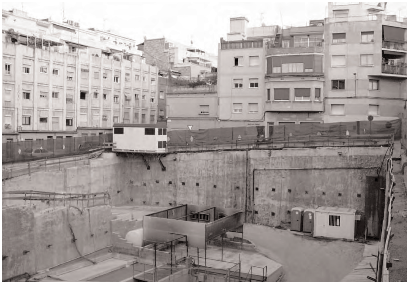
El projecte de prolongació del metro preveu noves estacions intermèdies i l'adaptació de les existents a persones amb mobilitat reduïda. Foto: Marta Casas.
