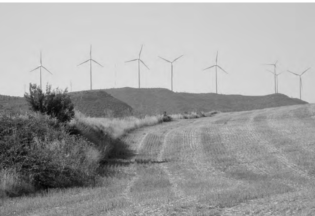
El parc inclou 33 aerogeneradores amb potencial energètic per 30.000 famílies. Foto: Alfons Recio Raja
