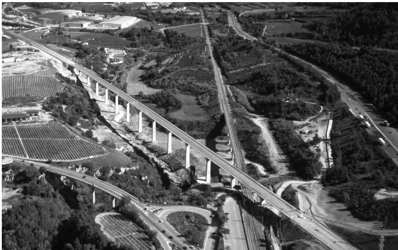
En la imatge, al seu pas pel viaducte Sant Sadurní. Foto: Adif
