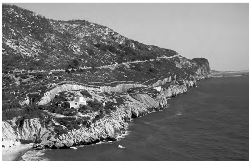
L'estratègia és 'aprofitar trams de vies fèrries convencionals amb senzilles operacions d'adaptació. Foto: Adif
