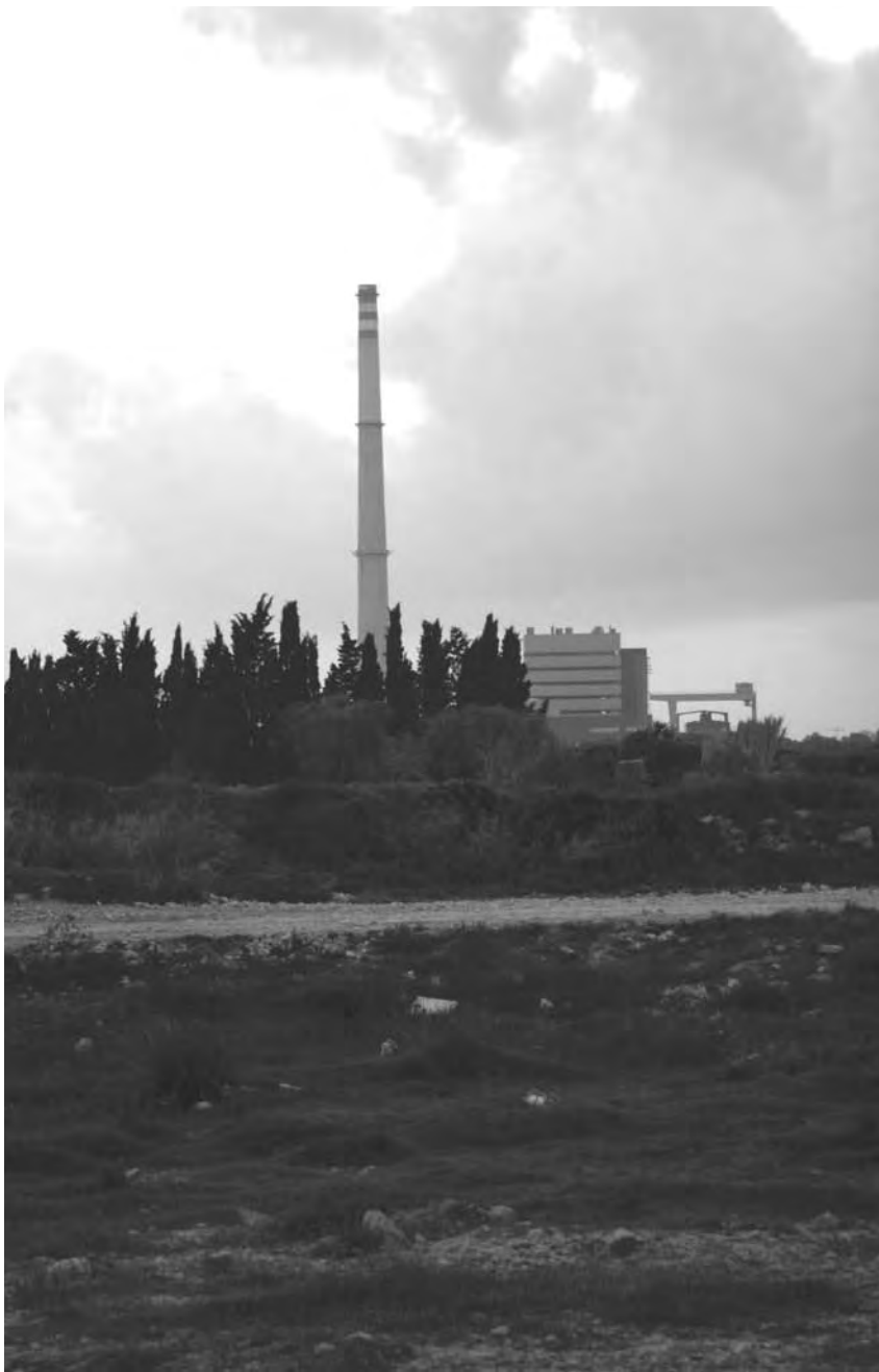
El 29 d'agost es va aprovar la llicència d'obres per la construcció de la central tèrmica. Foto: Marta Casas.
