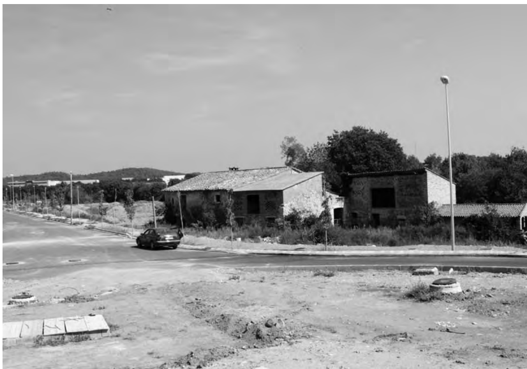
El pla preveu la construcció de 1.200 habitatges i el 26% serien HPO. Foto: Marta Casas.
